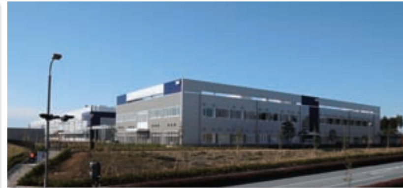
研究棟（写真手前）
