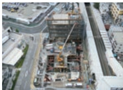
▲新丸子社宅跡地オフィスビル建設風景
